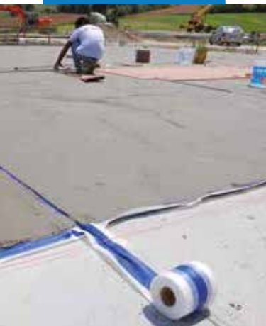
Хидроизолационни замазки с Mapelastic и Mapeband
