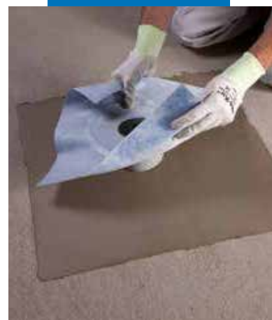
Drain Vertikal върху Mapelastic
