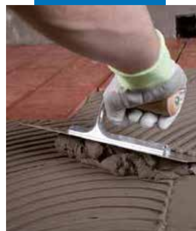
Полагане на Granirapid върху тераса, хидроизолирана с Mapelastic
