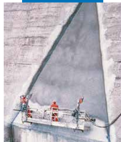
Пример за Mapelastic , положен върху язовир чрез впръскване
