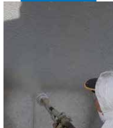
Пример за полагане на Mapelastic върху виадукт чрез впръскване
