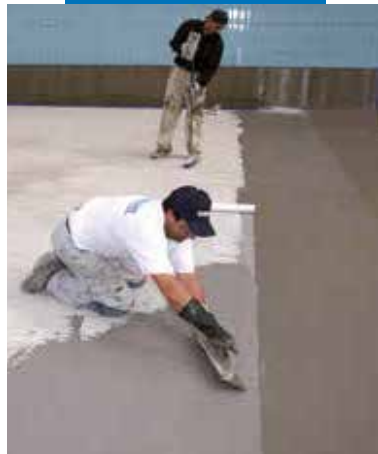
Хидроизолация на плувен басейн с Mapelastic
