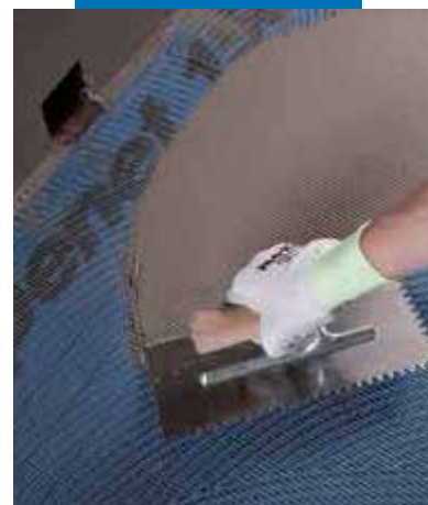
Полагане на Mapelastic върху Mapenet 150
