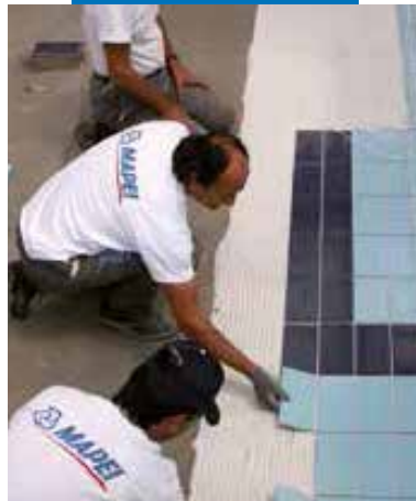
Полагане на керамични плочки върху Mapelastic в плувен басейн
