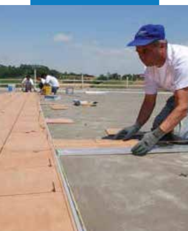
Полагане на керамика с Kerabond + Isolastic
